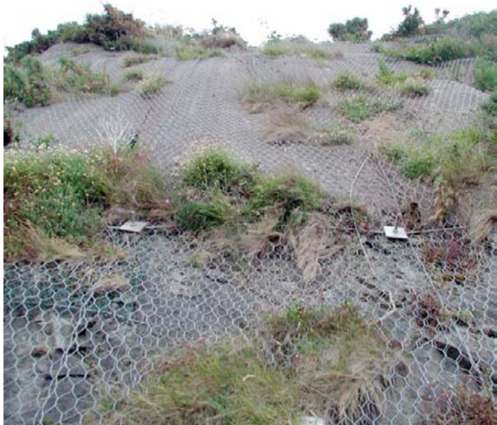
Skalná stena s inštalovanou geosieťou a už vyrastajúcou vegetáciou
