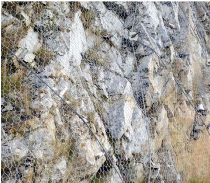
Protierózna ochrana svahu ľahko tvarovateľnou oceľovou geosieťou
