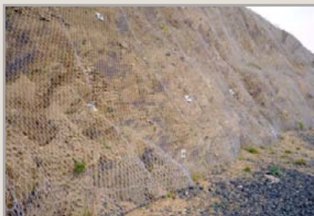
Ukotvená geosieť v cestnom záreze
